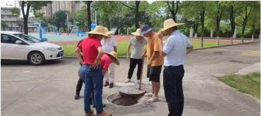
图 7.3.4-2: 学校雨污工程验收现场
